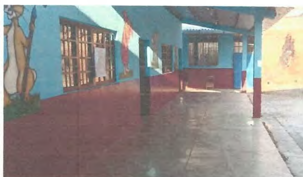
MEJORAMIENTO E INSTALACION DE PISO CERÁMICO EN AULAS, COCINA Y CORREDORES
