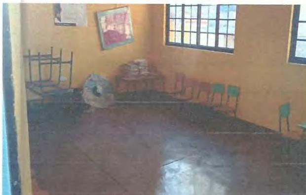
MEJORAMIENTO E INSTALACION DE PISO CERÁMICO EN AULAS, COCINA Y CORREDORES
