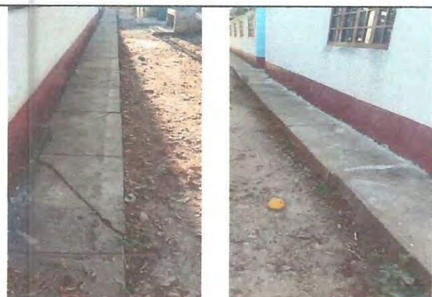
REPARACION Y MEJORAMIENTO DE BANQUETAS DE TRES AULAS, ESPESOR DE 0.12 M.
